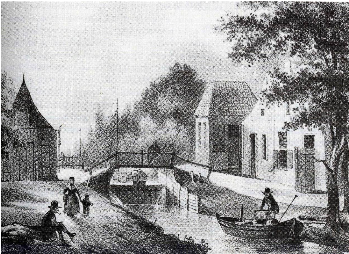
In de 18 e eeuw werden er in de buitengebieden van Hoogeveen drie schutten aangelegd. Dit keer niet voor de watervoorziening van de vaart, maar om het water achter de schutten zodanig op te stuwen dat er bevaarbare wijken ontstonden. Het waren de verlaten c.q. schutten in de Schutswijk, bij Veenlust (nu Coevorderstraatweg) en het Noordsche Schut. We kennen een afbeelding van Veenlust. In dat geval ging het om een schut met draaideuren. Dit vraagt om nader onderzoek.
