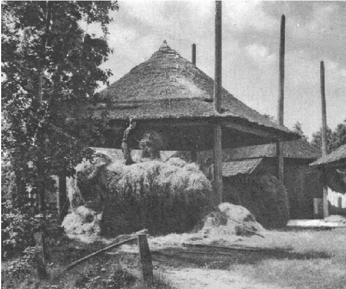
Een kapschuur, met een in hoogte verstelbaar dak, in gebruik als bergplaats voor hooi. Een dergelijke kapschuur stond aan het begin van de huidige Wolfsbosstraat als schaapskooi van de Hollandse Compagnie.
