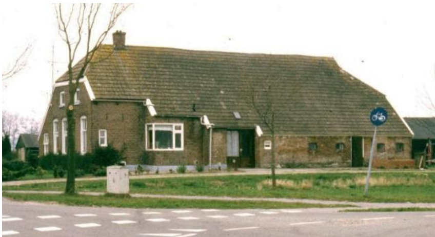
Hollandscheveldse Opgaande no. 19, afgebroken in oktober 1998.
