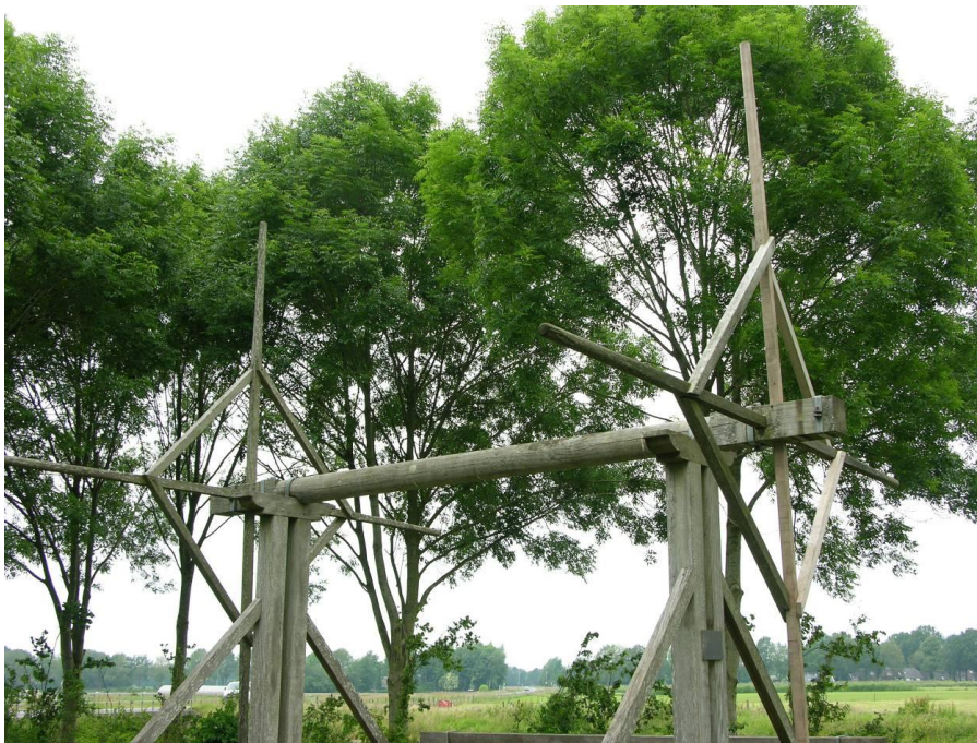
Bij Dwingeloo is het bovenstuk van een verlaat opnieuw opgebouwd.
