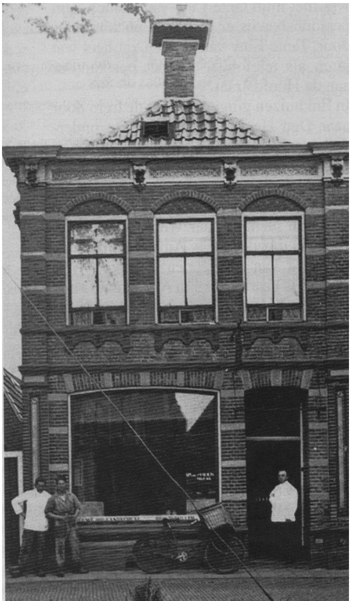
Slagerij Van Zuiden, Hoofdstraat 207. Het pand is nu afgebroken en stond op de noordhoek van het huidige pand van de HEMA.
